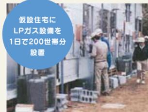
仮設住宅にLPガス設備を1日で200世帯分設置
